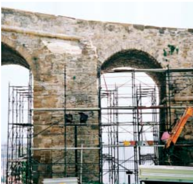
Bergamo Alta Porta San Giacomo. Consolidamento del viadotto mediante l'inserimento di tiranti "a dispersione" e successiva iniezione di materiali compatibili a quelli esistenti.
